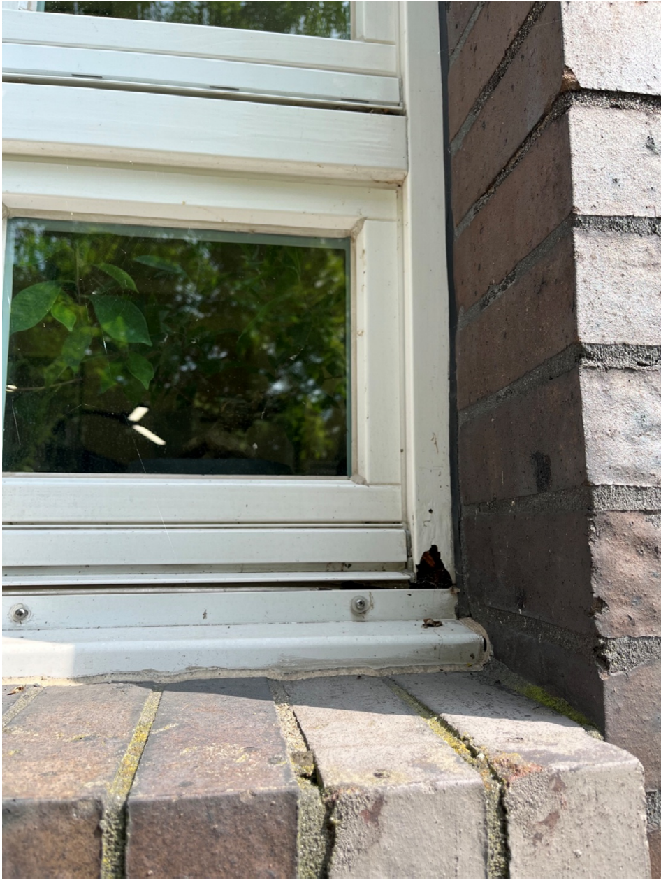
Amtsgebäude Fenster EG
