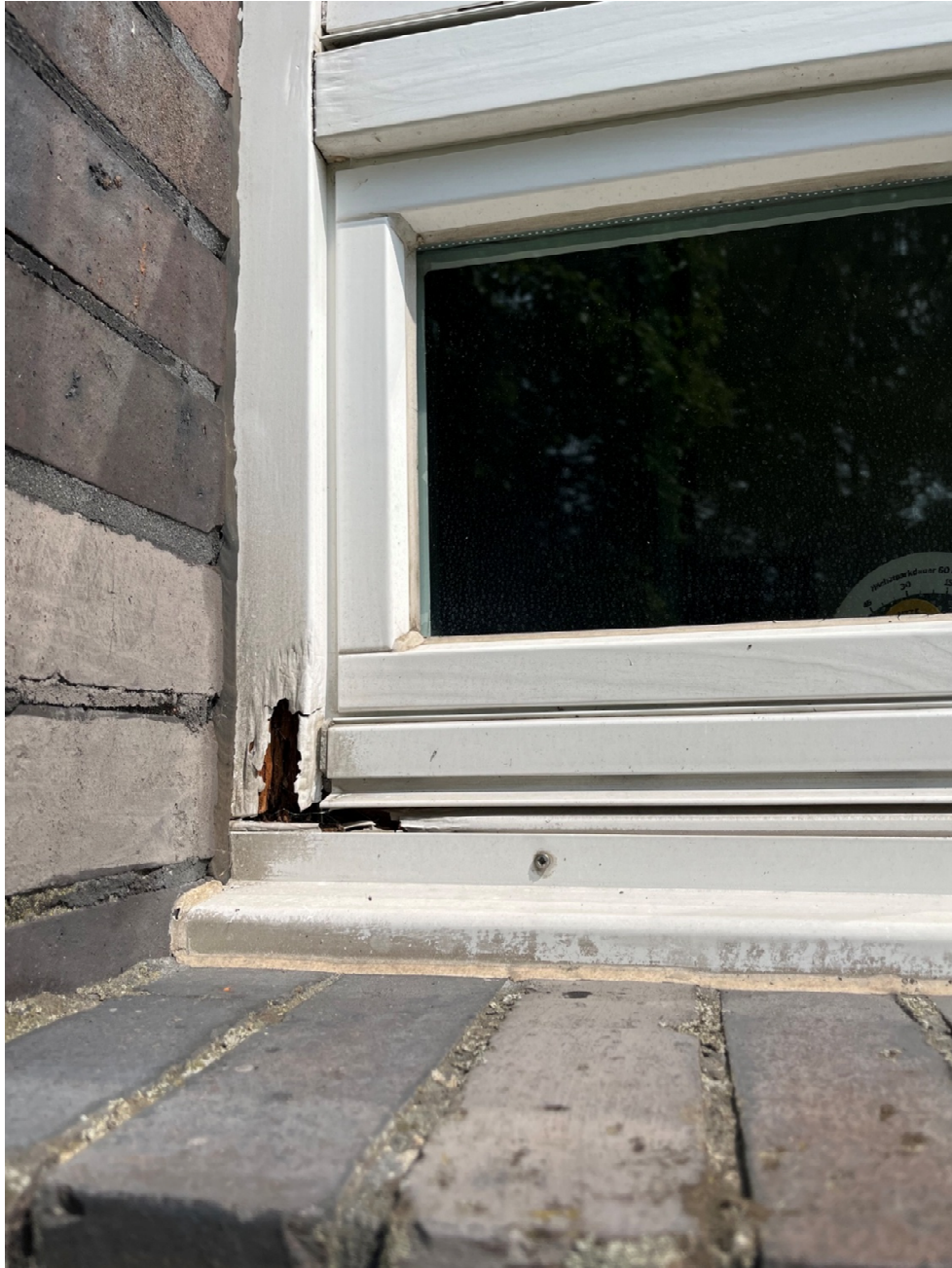
Amtsgebäude Fenster EG
