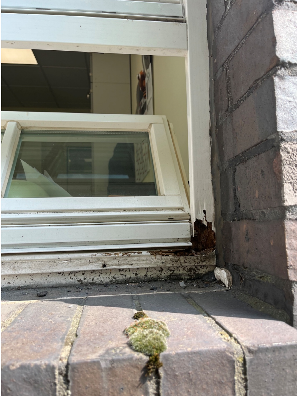
Amtsgebäude Fenster EG
