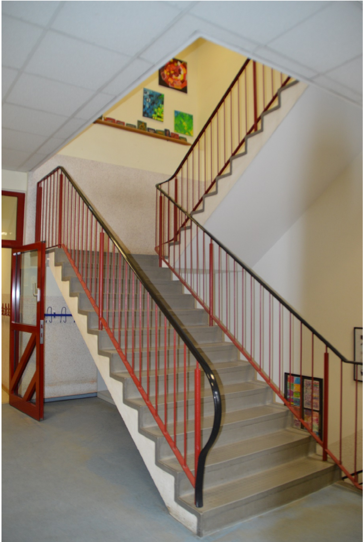
Treppenhaus 1. OG zu 2. OG, Detail Treppengeländer
