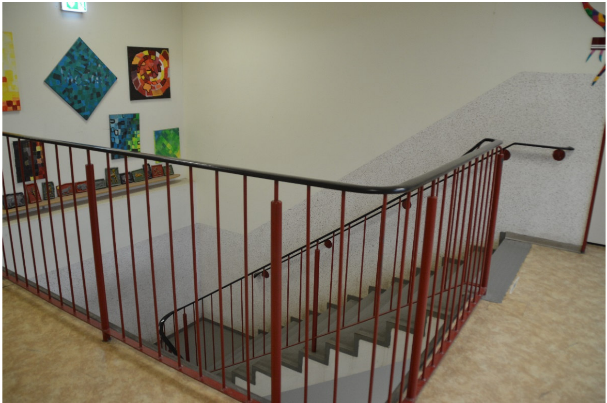
Treppenhaus 2. OG, Detail Brüstungsgeländer
